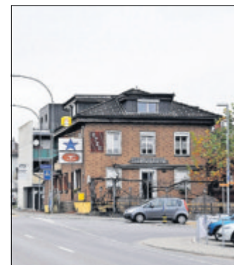
Das Gebäude an der Kreuzstrasse 29.
